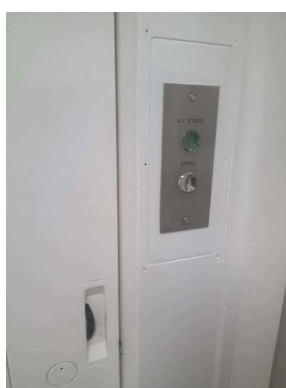
Commande palière du niveau principal
